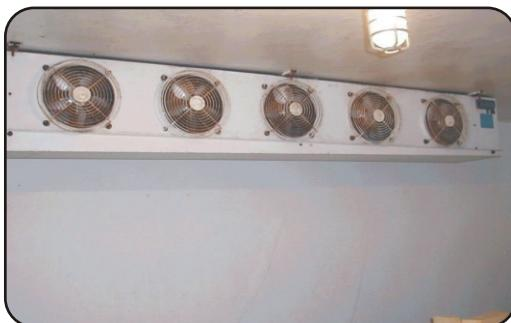
Cada cámara de refrigeración utilizada para almacenar y/o guardar producto tendrá fijado un termómetro para medir la temperatura. Este aparato deberá registrar la temperatura instalada en forma exacta dentro de la cámara, y deberá fijarse con un regulador de control automático o con un sistema de alarma el cual indique cambios de temperatura significativos en su operación manual.
